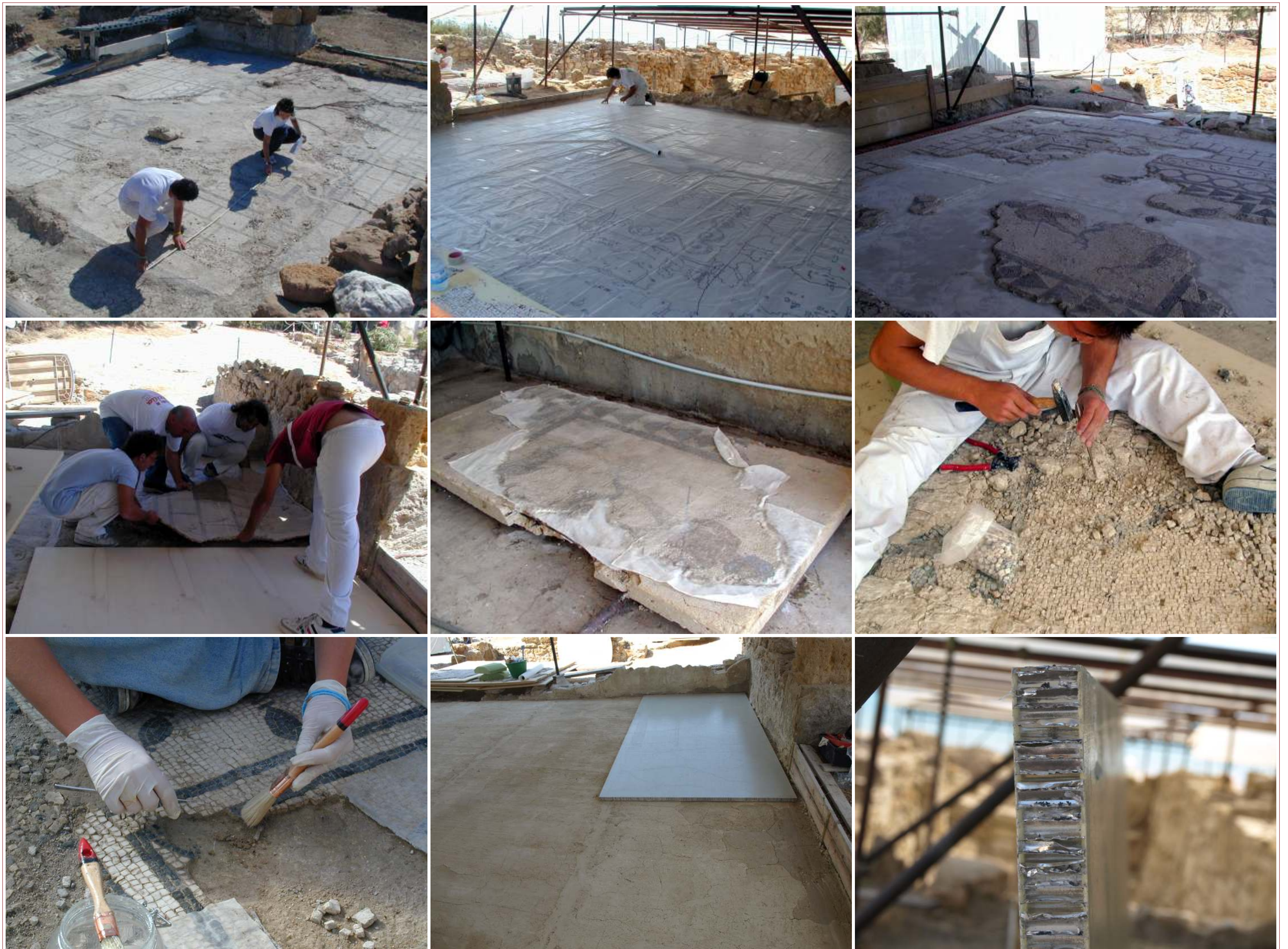
Alcune fasi del restauro della pavimentazione in opus tessellatum dell' apodyterium delle terme di Nettuno.
