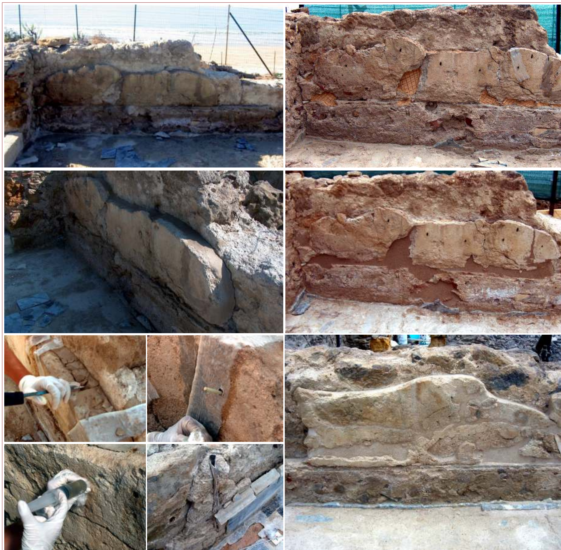
Alcune fasi del restauro delle murature e dei rivestimenti murari.
