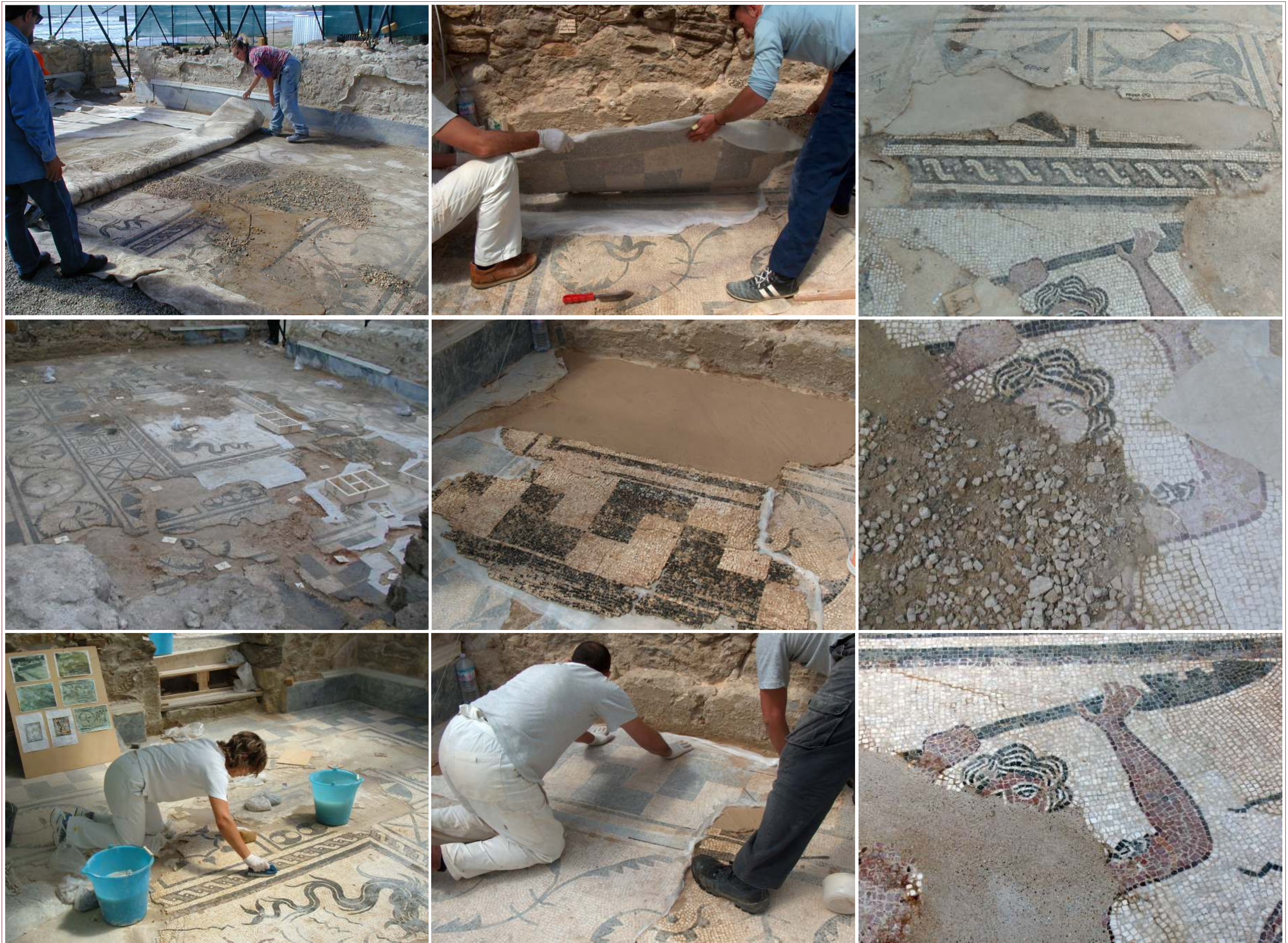
Alcune fasi del restauro della pavimentazione in opus tessellatum dell' apodyterium delle terme di Scilla.
