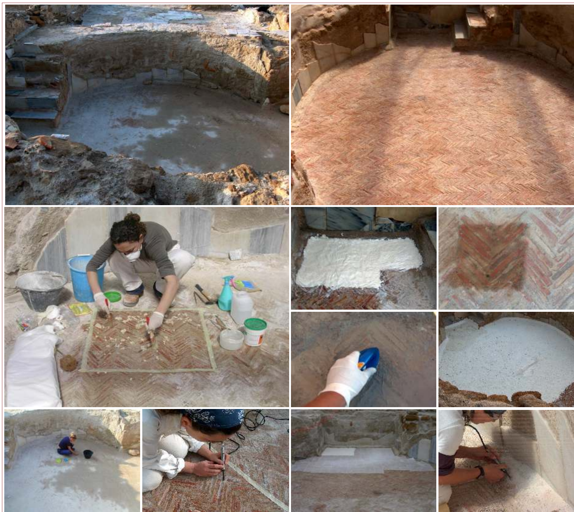
Alcune fasi del restauro della pavimentazione in opus spicatum della vasca del frigidarium .
