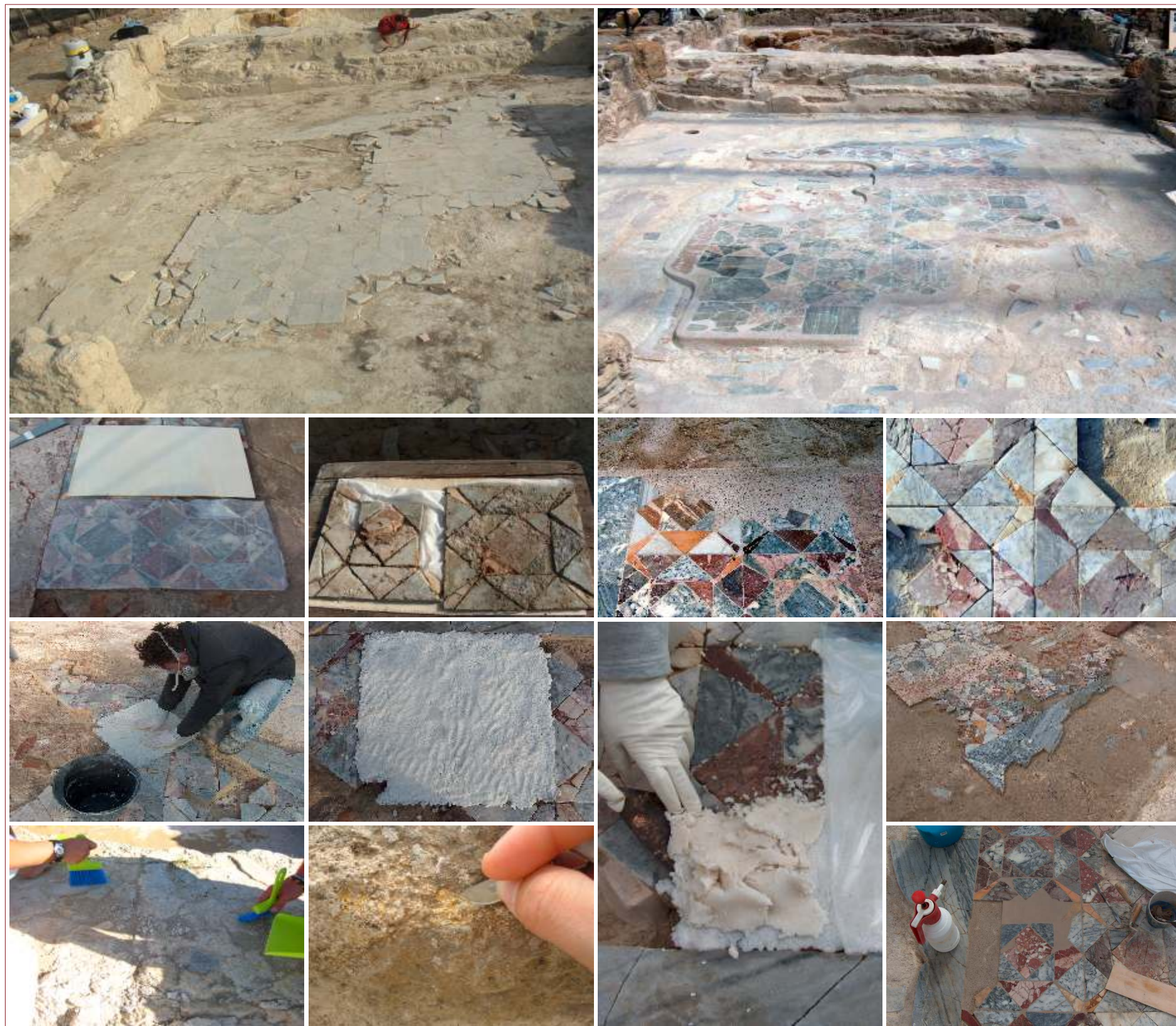
Alcune fasi del restauro della pavimentazione in opus sectile del frigidarium .
